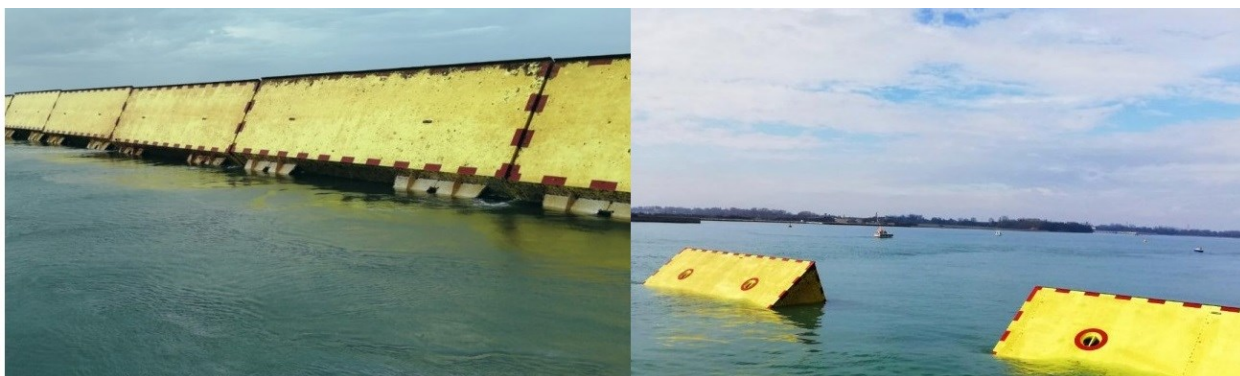
Рисунок 30. Подъём защитных ворот MOSE в момент опасного повышения уровня Венецианской лагуны.
