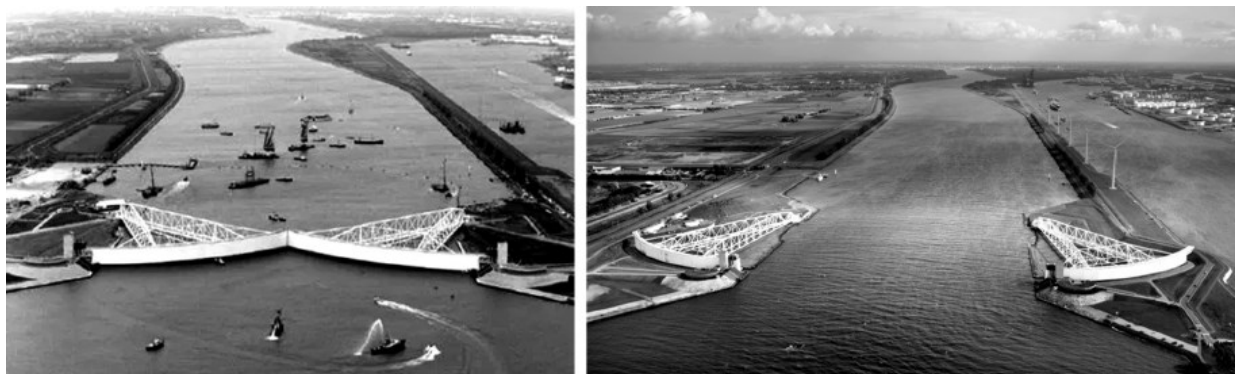
Рисунок 32. Закрытые и открытые затворы Масланткеринга. [72]
