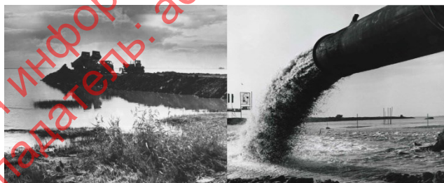
Рисунок 19. Намыв новых территорий под северной строительной площадкой «Горская» [53]
