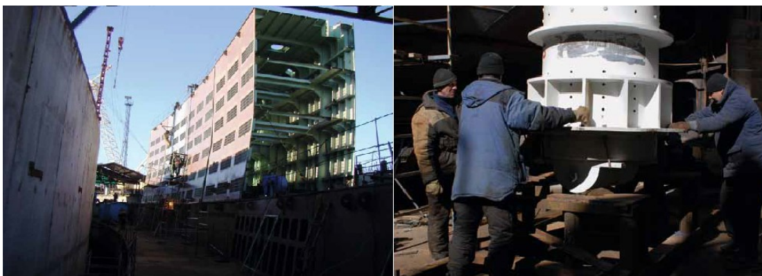
Рисунок 25. Монтаж системы ботопортов на сооружении С-1 в 2008 г. [59]
